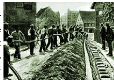
Pose d'un câble téléphonique dans les années 50
